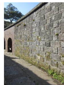
a.千代ヶ崎砲台
