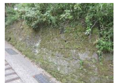
写真-6.6 おすすめ「ブラフ積み擁壁」No.4 稲荷山の坂
