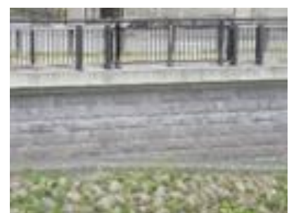
写真-5.2 勝納川擬岩護岸
