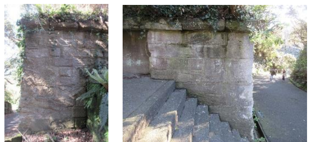
写真-6.17 No.23 第 2 砲台 No.30 第 1 砲台
