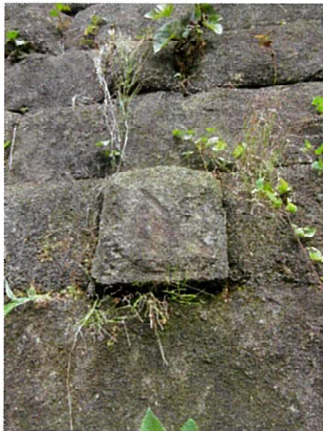
②上 房州石 鈴木家? ②③境界部の施工状況 ②方向 施工状況が明確
