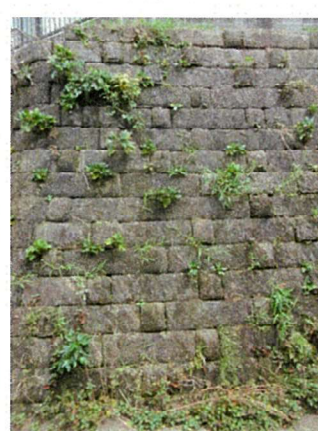
②上 房州石 鈴木家? ②③境界部の施工状況 ②方向 施工状況が明確
